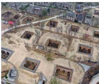
Slika 3. Yaodong podzemne zgrade ukopane u terenima [7]
