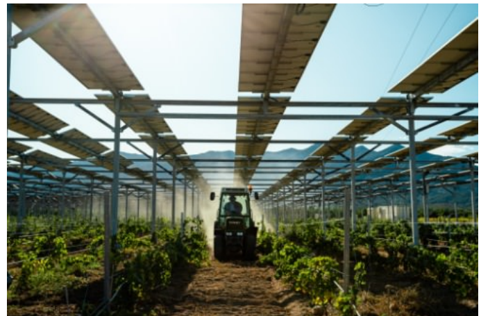
Slika 3. APV sistem sa visokom montažnom konstrukcijom
