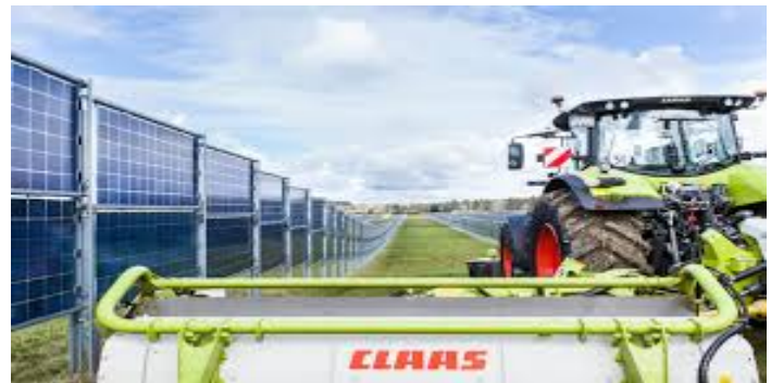
Slika 2. APV sistem sa vertikalnim panelima
