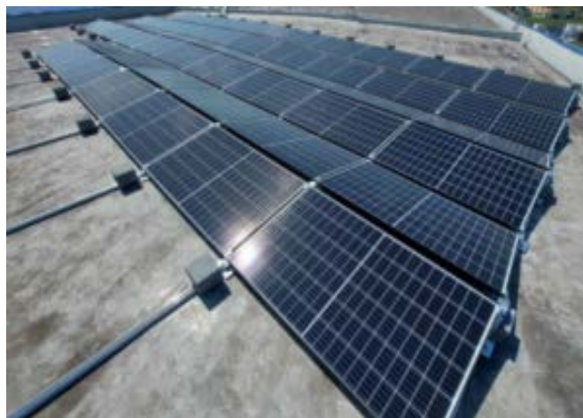
Slika 1. Solarna elektrana na krovu NTP Čačak
